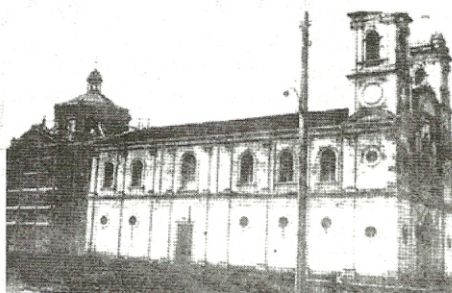
Construção da catedral de Barretos, 1915
