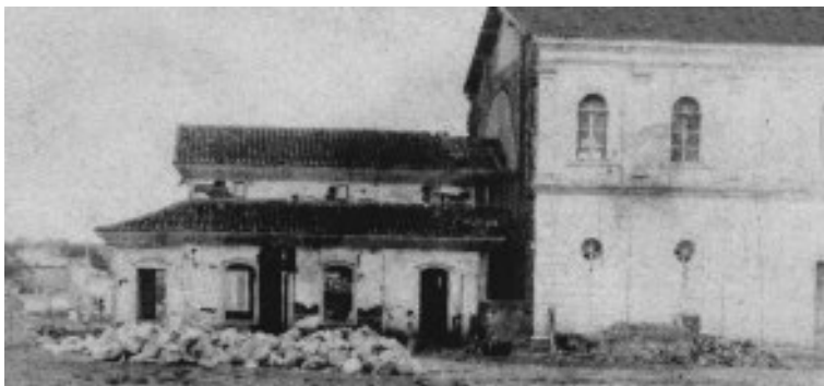
Vista do restante da capela anterior, lado da rua 18. Derrubado, nesse local foi construído o presbitério e a cúpula da nova igreja.
